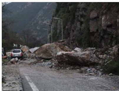
Καταπτώσεις βράχων στην περιοχή των Τεμπών 12/2009
